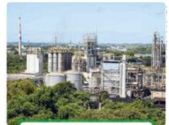
Vista do Polo Industrial de Camaçari (BA), em 2015.
